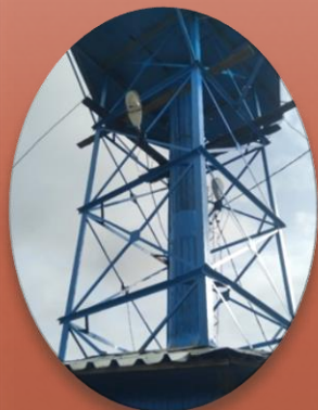
Ремонт резервуара на водонапорной башне п. Лемтыбож
