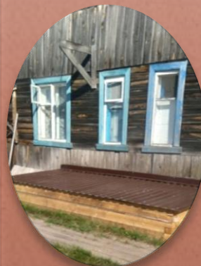
Ремонт выгребных ям с. Дутово
