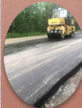
Выполнение работ по ямочному ремонту автомобильной дороги общего пользования местного значения «Пост ДПС- Нефтебаза»
