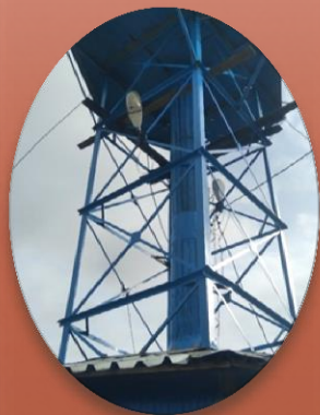
Ремонт резервуара на водонапорной башне п. Лемтыбож
