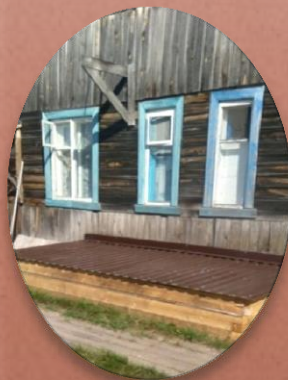
Ремонт выгребных ям с. Дутово
