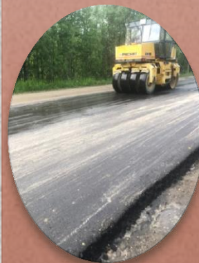
Выполнение работ по ямочному ремонту автомобильной дороги общего пользования местного значения «Пост ДПС- Нефтебаза»
